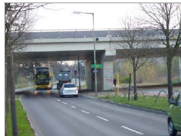
Autobahnbrücke im Zuge der A10 über die Karower und Bucher Chaussee
